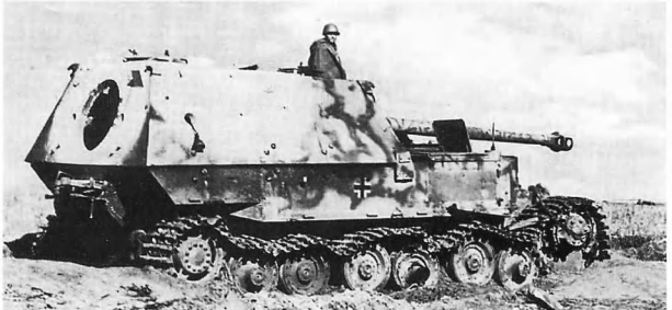
Подорвавшийся на mine и захваченный бойцами Красной Армии "Фердинанд". Хорошо виден эвакуационный люк
