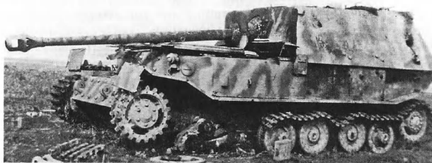
"Фердинанд", уничтоженный "зверобоем": 152-мм снаряд хотя и не пробил лобовую броню, просто вдавил лобовой лист внутрь танка!
